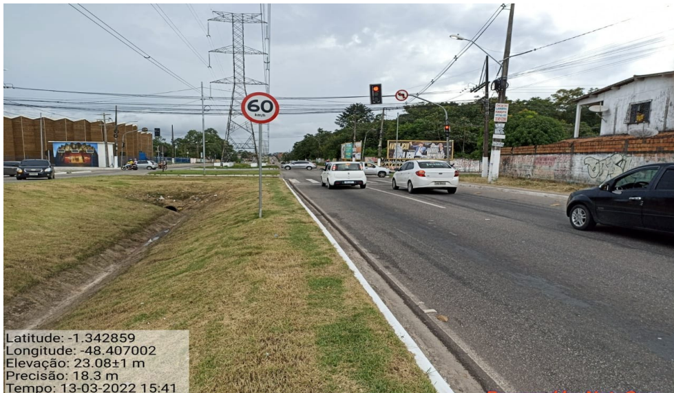
PLACA R19 - JUNTO DO EQUIPAMENTO
