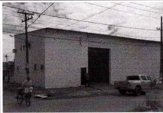
Foto 1: Vista da fachada do galpão.
