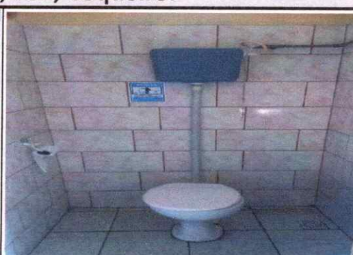
Foto 2: Vista do banheiro do piso inferior.
