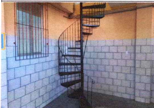
Foto 2: Vista da escada.
