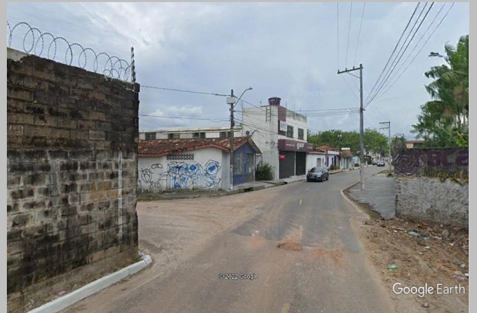
Final do trecho da Passagem Damasceno
