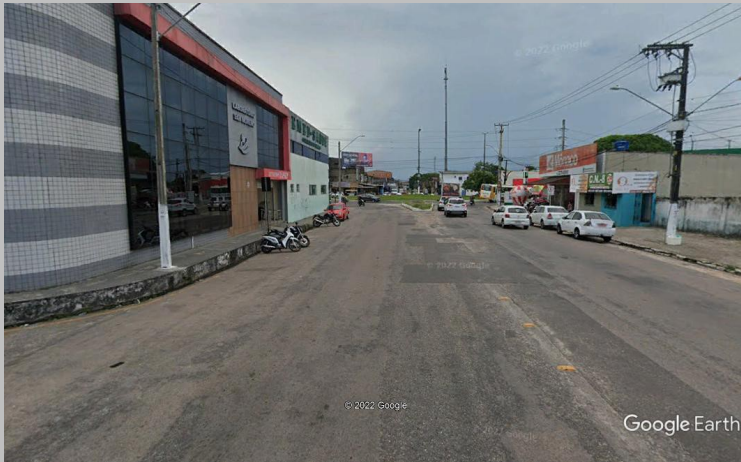
Rua da Providência com a Arterial 5
