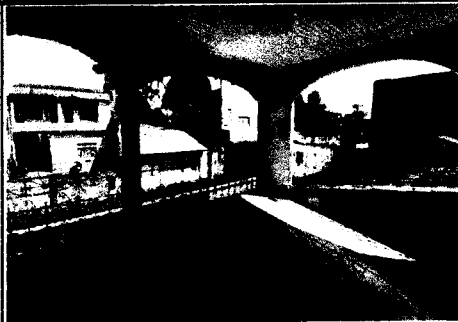
Foto 2: Vista do pátio interno no pavimento superior
