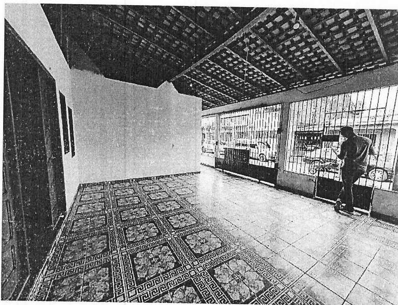
ESPAÇO INTERNO (garagem sem forro)
