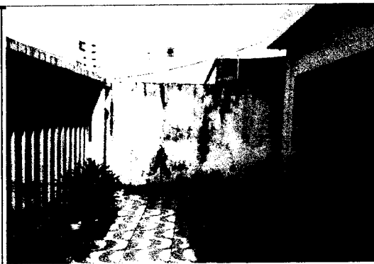
Foto 2: Área da recepção.
