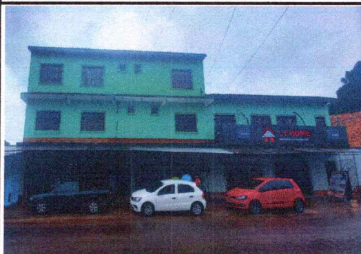
Foto 1: Vista da Fachada do imóvel.
