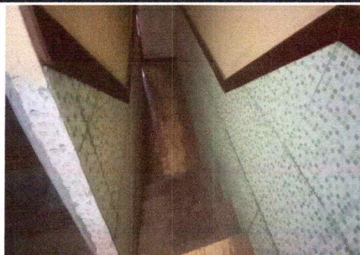
Foto 1: Vista da escada.
