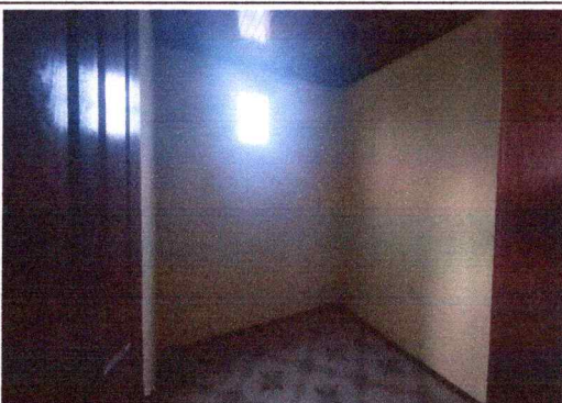
Foto 4: Vista da sala.
