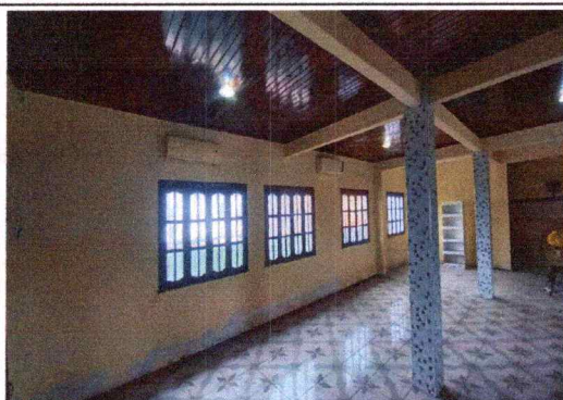
Foto 3: Vista do salão com 04 centrais de ar.
