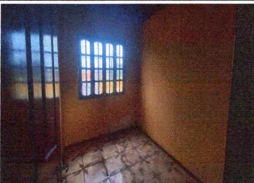
Foto 6: Vista da sala.
