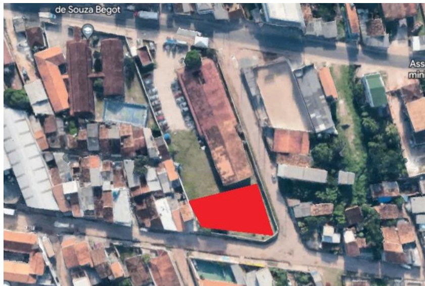
Ilustração 3 – Imagem aérea da construção do Centro de especialidades odontológicas CEO ÁGUAS LINDAS
