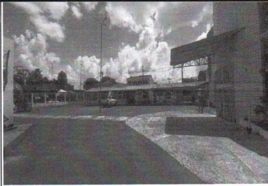
Foto 2: Vista da área externa do imóvel.
