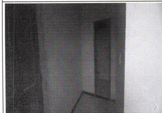
Foto 5: Vista do acesso ao banheiro.
