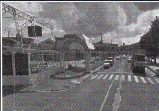
Foto 1: Vista da fachada do imóvel na arterial 18, Cidade Nova.
