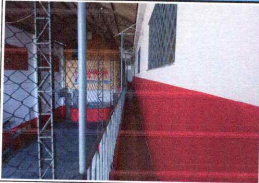
Foto 1: Vista do corredor do pavimento superior.
