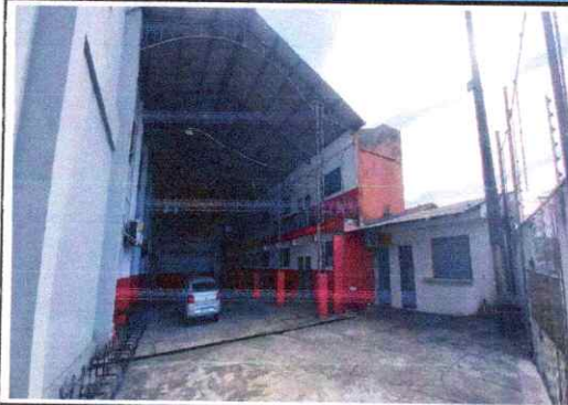
Foto 1: Vista da entrada.
