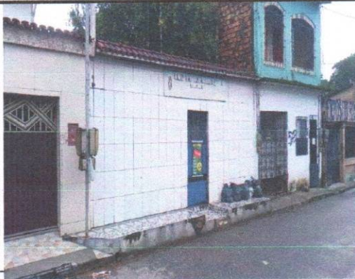
Foto 7: Vista da fachada
