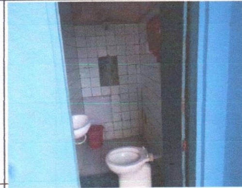
Foto 12: Vista do banheiro.
