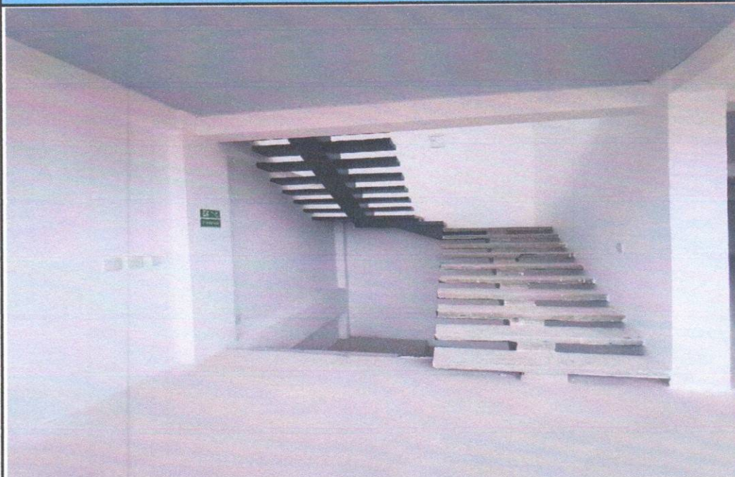
Figura 01: Vista da escada incabada.
