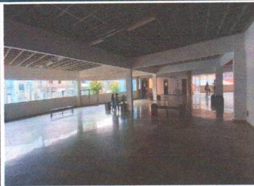
Foto 2: Vista do pátio interno.
