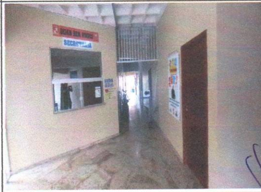
Foto 6: Vista do corredor.
