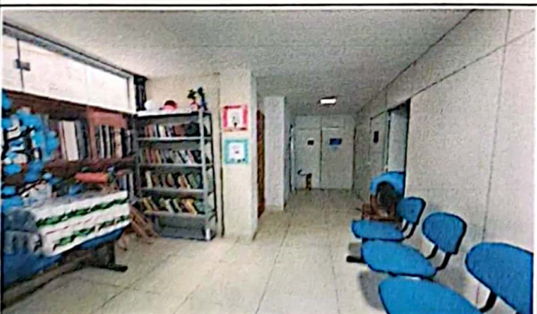
Foto 9: Hall superior ambientado, em piso revestido, esquadrias em vidro e MDF, forro em gesso, divisória naval, iluminação embutida de led e extintor de incêndio.
