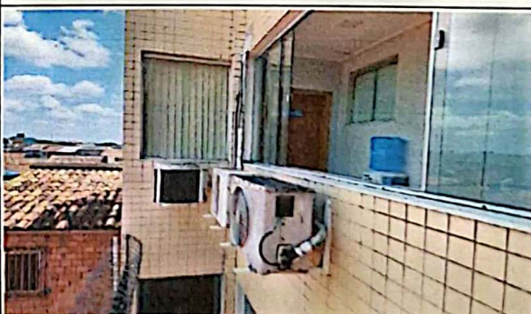
Foto 16: Fachada lateral revestida em pastilhas cerâmicas, vãos de ventilação em vidro, suporte de fixação de sistema de climatização e cerca concertina em muro.
