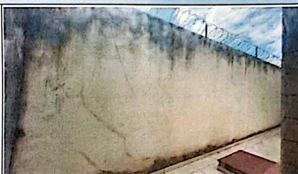
Foto 18: Área externa posterior em piso revestido e muro cercado com concertina
