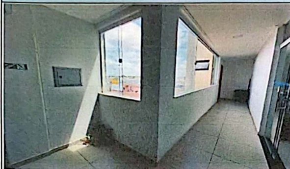
Foto 11: Corredor superior com vão com esquadria em vidro, pintura acrílica, piso revestido, iluminação embutida de led e sinalização de segurança.
