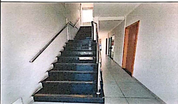
Foto 7: Escada de acesso ao pav. Superior revestida em granito com rachuras antiderrapantes e corrimão em aço inox.
