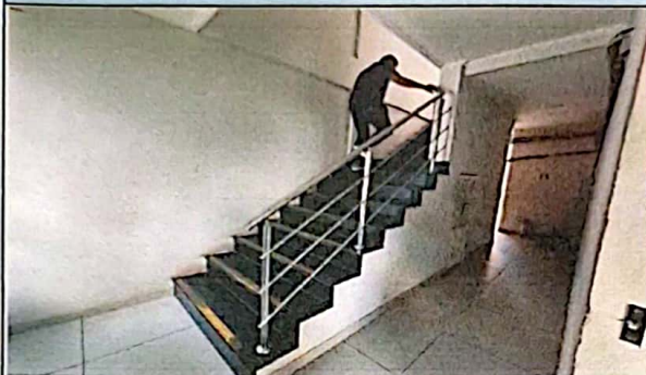
Foto 5: Escada de acesso ao pav. Superior revestida em granito com rachuras antiderrapantes e corrimão em aço inox.
