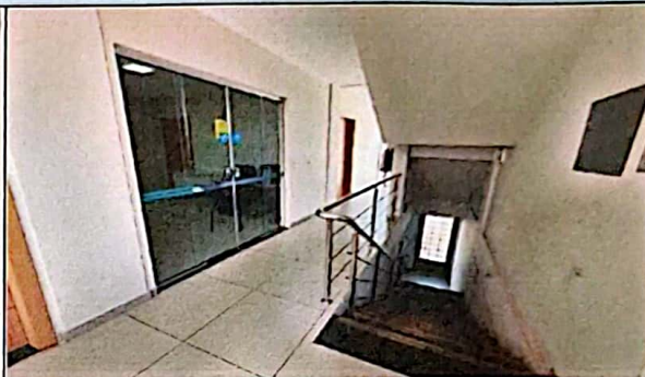
Foto 6: Pav. Superior em piso revestido, esquadrias em vidro e MDF, paredes em pintura acrílica e forro em gesso.
