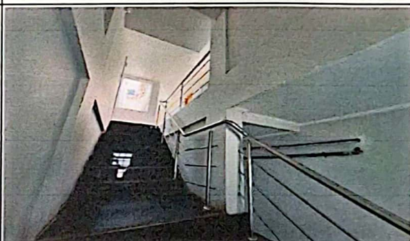
Foto 8: Escada de acesso ao pav. Superior revestida em granito com rachuras antiderrapantes e corrimão em aço inox.
