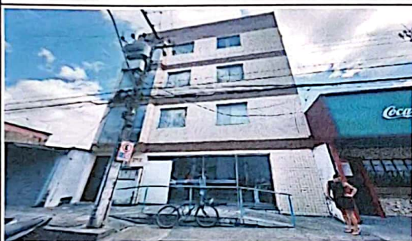
Foto 1: Fachada revestida em pastilhas cerâmicas com esquadrias de acesso e de vedação em vidro e rampa de acessibilidade.
