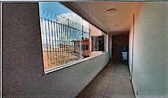
Foto 12: Corredor superior com vão em esquadria em vidro, pintura acrílica, piso revestido e iluminação de led.
