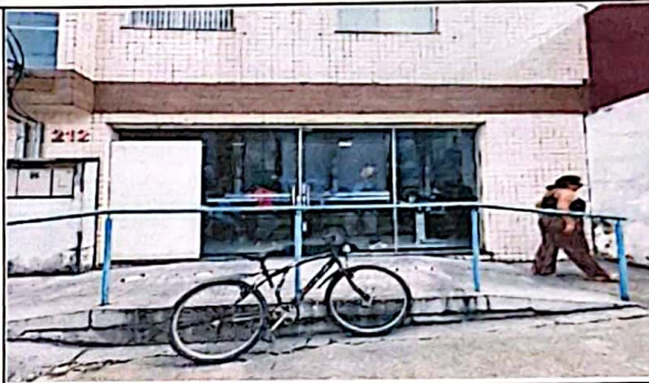
Foto 1: Detalhamento de rampa de acessibilidade em piso de concreto e corrimão.
