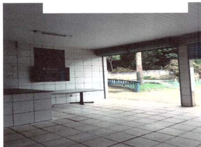
Estrutura da Cobertura
