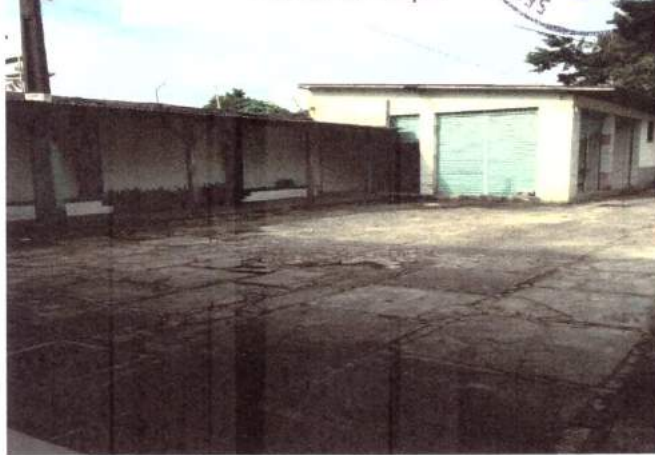
Interior do Galpão
