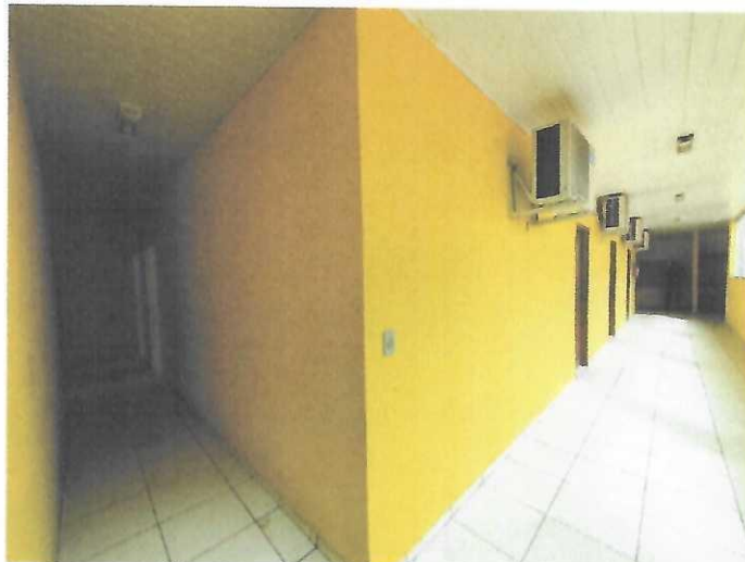
CIRCULAÇÃO 2º PAVIMENTO
