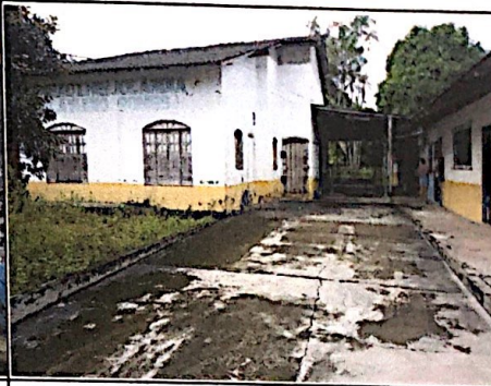
Foto 5: Vista do corredor de acesso.
