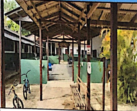
Foto 2: Vista do corredor de acesso.
