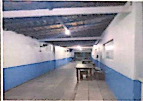
Foto 2: Vista do corredor de acesso.
